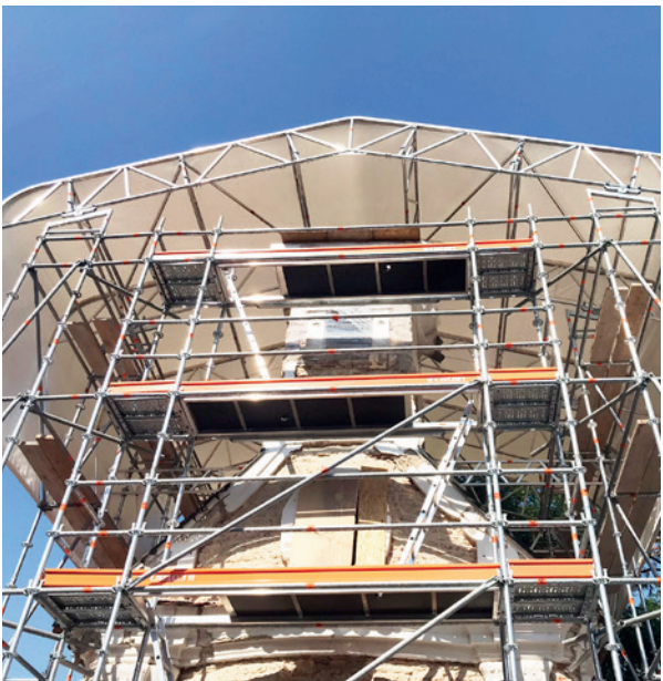
Restauration – Système de couverture Keder, Zagreb, Croatie
