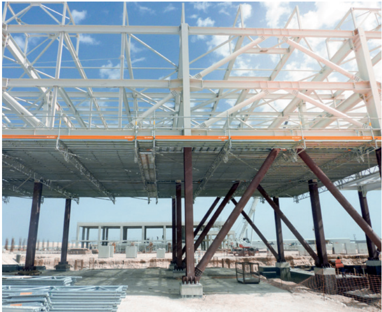
Piperack, Garabogaz – Usine d'engrais, Turkménistan
