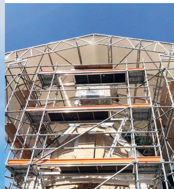
Restauration – Système de couverture Keder, Zagreb, Croatie
